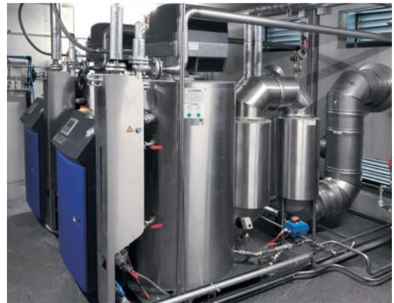
Abb.: Mehrfachdampfananlage mit zweitem Economiser auf Grundgestell
